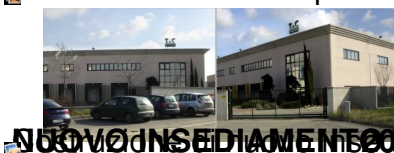
Realizzazione di complesso artigianale posto in Cascine di Buti, zona industriale La Tura.
